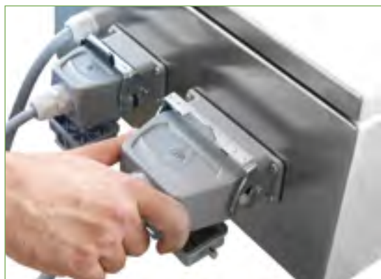
Připojení výrobníku do rozvaděče
